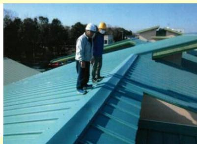
←「カバー工法」により屋根の上にさらに屋根をかぶせ、ピカピカの屋根に生まれ変わりました！
